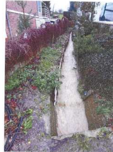
Fosse d'évacuation des eaux d'un des bassins de la rocade et traces de débordement de celui-ci sur la voirie.
