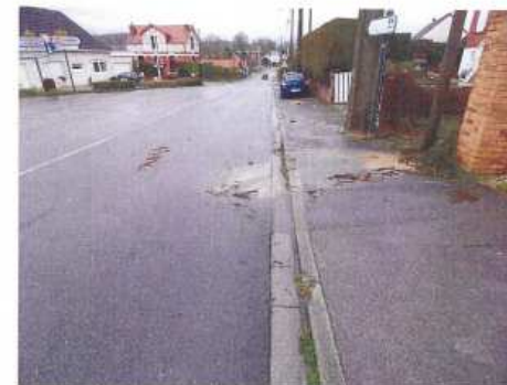
Fosse d'évacuation des eaux d'un des bassins de la rocade et traces de débordement de celui-ci sur la voirie.
